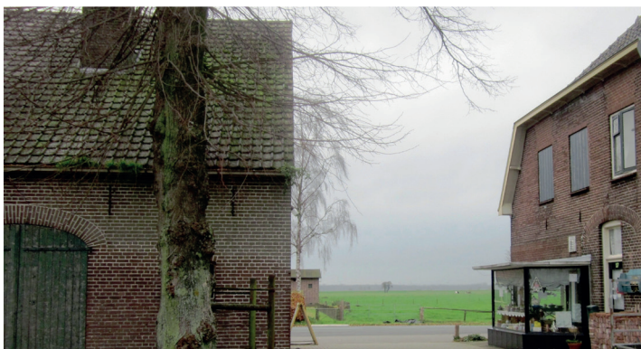
Rechts het woonhuis uit 1909, links de nieuwe bedrijfsruimte uit 1929 met achter de boom de hoofstal. In de gevel van het woonhuis is de deuropening van de inpandige smederij nog zichtbaar.
